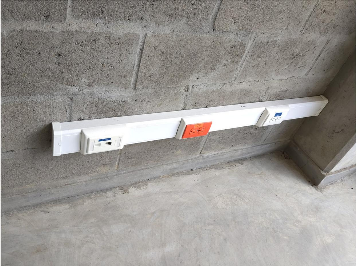
Imagen 7 Canaleta de sobreponer existente en laboratorios
